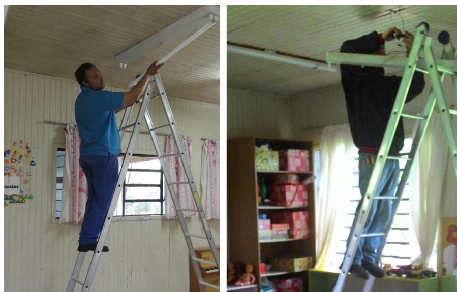
Figura 2 – Substituição de lâmpadas e reatores
